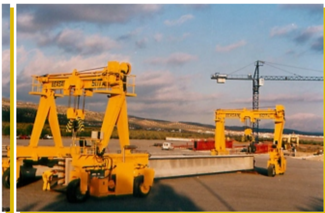
MANIPULACIÓN DE VIGAS DE HORMIGÓN
