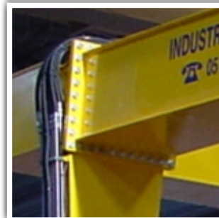
ESTRUCTURA ATORNILLADA FÁCILMENTE DESMONTABLE
